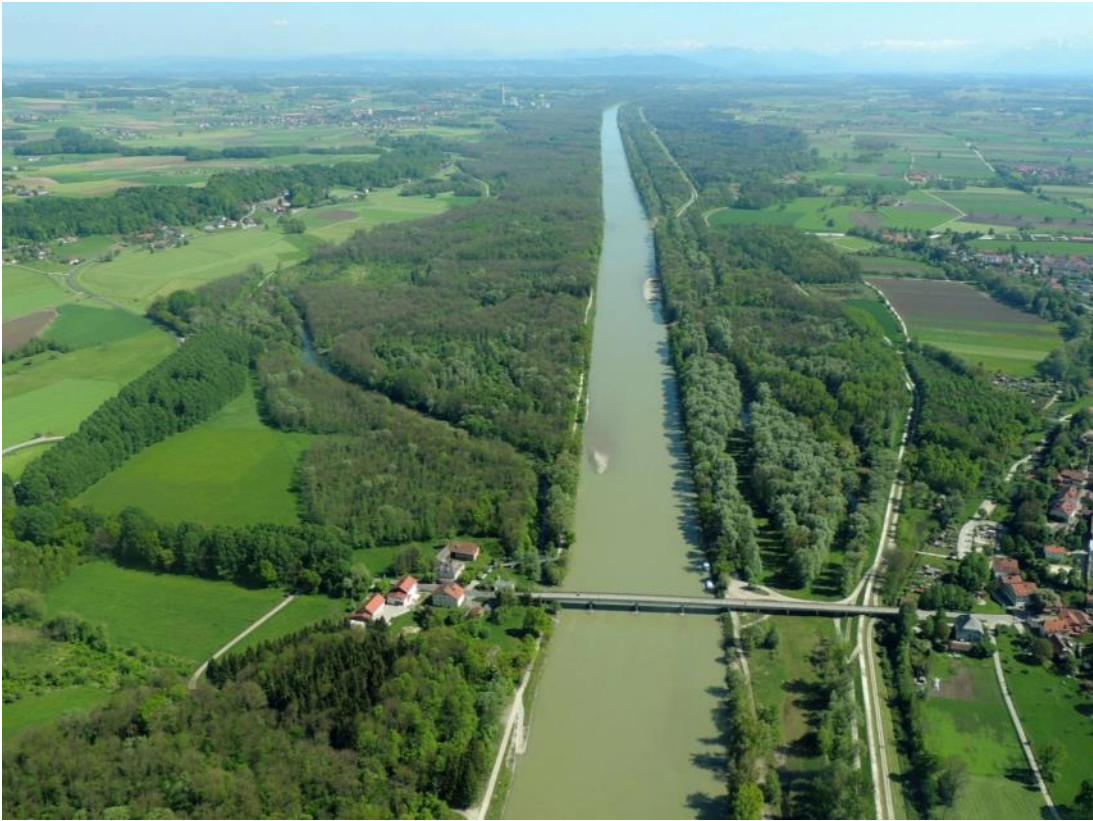
Die Salzach im Tittmoninger Becken - Blickrichtung von der Tittmoninger Brücke Richtung Süden
