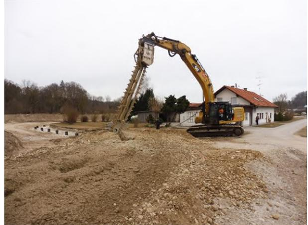
Abb. 4: Während im Vordergrund die Fräse arbeitet, sind im Hintergrund die Stahlträger zu sehen, die das Fundament bilden für die Hochwasserschutzmauer im Hirtener Ortsteil Au.
