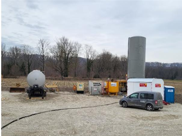
Abb. 3: Der Zement wird in einem Silo gelagert, Wasser kommt aus der Alz. Über einen dicken schwarzen Schlauch wird das Gemisch zur Maschine transportiert.
