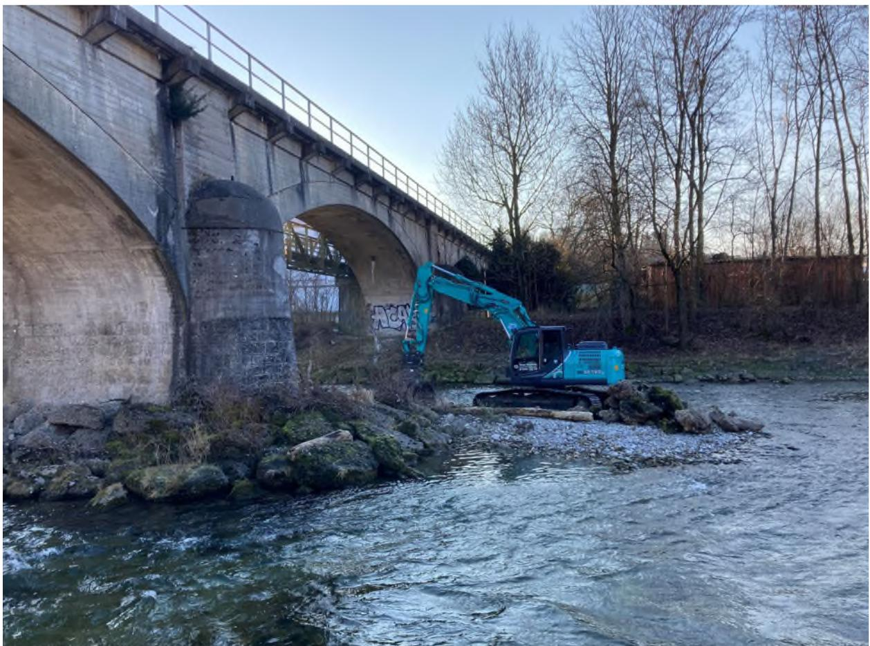
Abbildung 3: Ein Bagger gräbt die Uferverbauung aus Stein sowie Kies und Wurzeln aus. Foto: WWA TS
