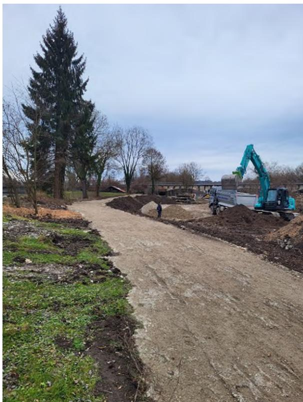
Abbildung 6: Der Weg entlang der Alz wurde für den Hochwasserschutz zurückversetzt. In einigen Abschnitten ist er bereits instandgesetzt.
