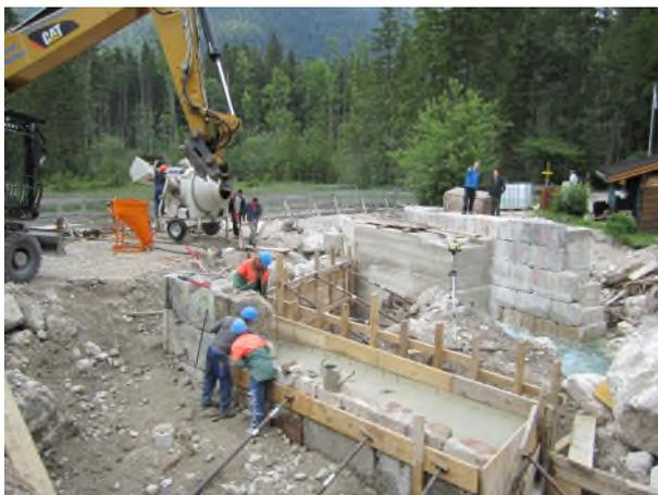
Abbildung 4: Die alten Steine werden von neuem Baumaterial ergänzt, nicht sichtbar eingebrachter Beton sorgt für Stabilität. Den Weg über die Seeklause setzt die Gemeinde Ramsau instand. Foto: Wasserwirtschaftsamt Traunstein
