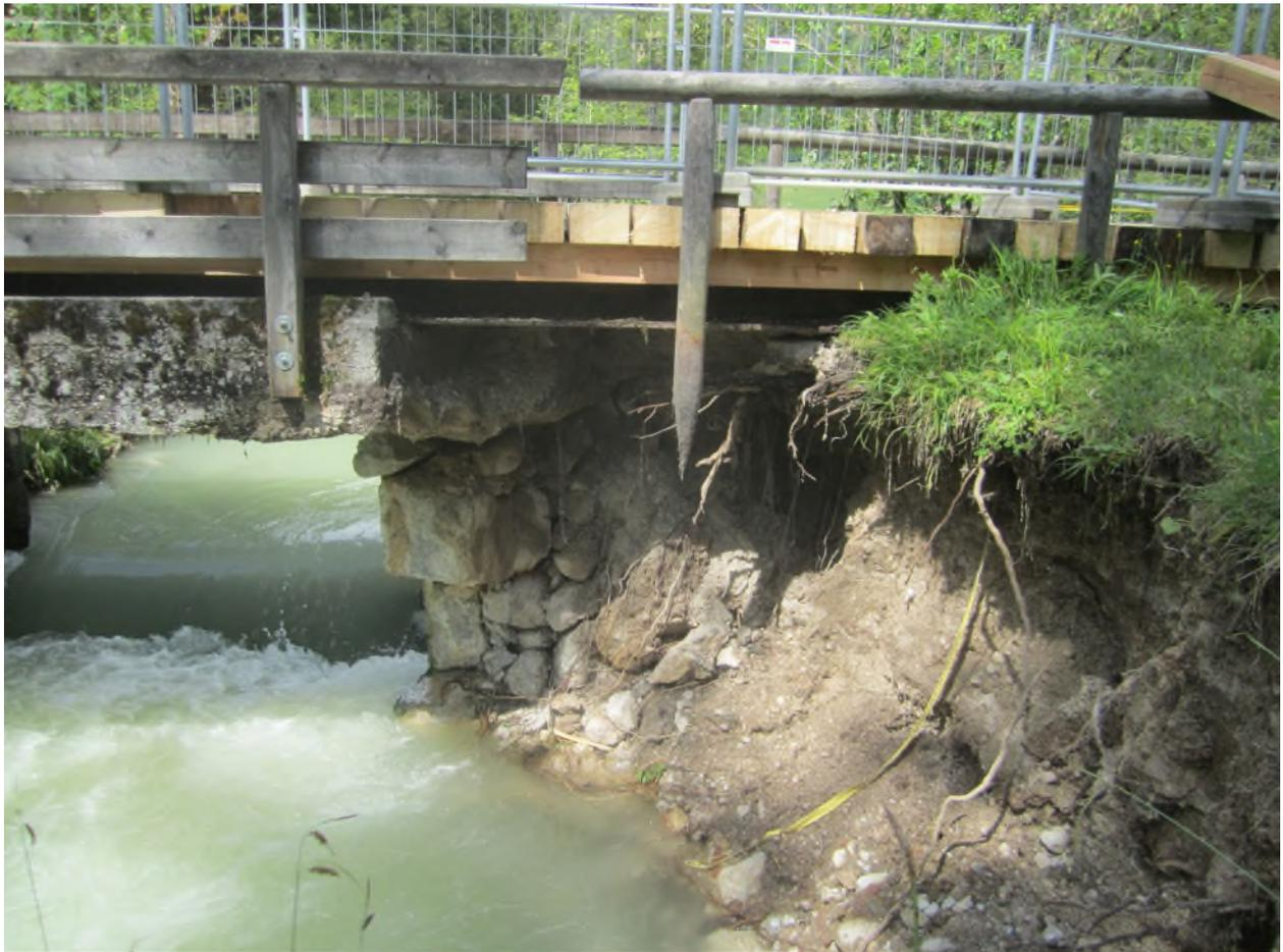
Abbildung 3: Die Kraft des Wassers hat für Auswaschungen gesorgt. Das Fundament der Seeklause ist nicht mehr stabil. Foto: Wasserwirtschaftsamt Traunstein
