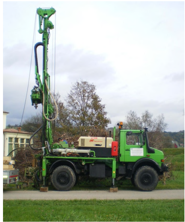
Abb. 2: Mit einem speziell ausgestatteten Unimog werden im Umkreis des geplanten Hochwasserschutzes Bohrungen bis zu einer Tiefe von zehn Metern vorangetrieben.
