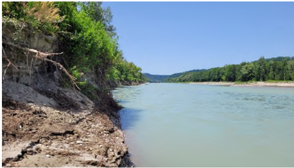
Abbildung 1: An einigen Stellen entlang der Unteren Salzach bei Tittmoning hat sich der Fluss bereits weiter in das Ufer hinein gegraben. Weil die Ufersteine ausgebaut sind, hat die Salzach mehr Platz und kann bei höherer Wasserführung Teile des Ufers mitnehmen. Foto: Wasserwirtschaftsamt Traunstein
