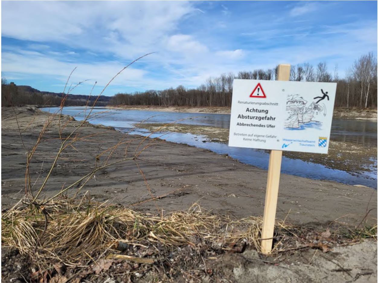
Abbildung 3: An einigen Stellen des Bauabschnittes sollten Fußgänger und Radfahrer die Uferzone der Unteren Salzach meiden. Hier kann es zu Uferabbrüchen kommen. Warningschilder sind aufgestellt. Foto: Wasserwirtschaftsamt Traunstein
