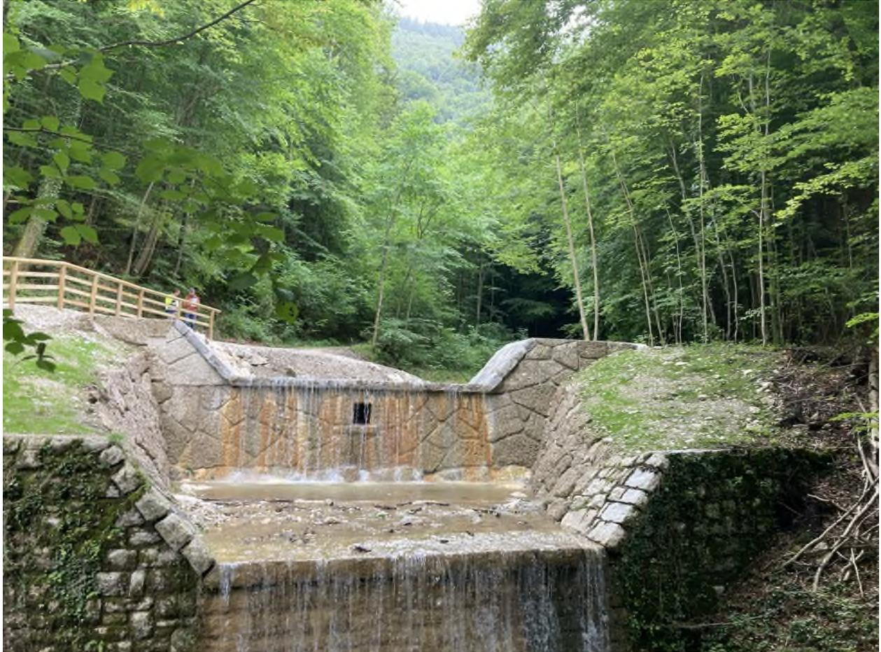
Abb. 1: Die neue Kiesfangsperre im Grießenbach bei Grassau gilt als wichtiges Hochwasserschutz-Element für die Menschen im Grassauer Ortsteil Grießenbach.
