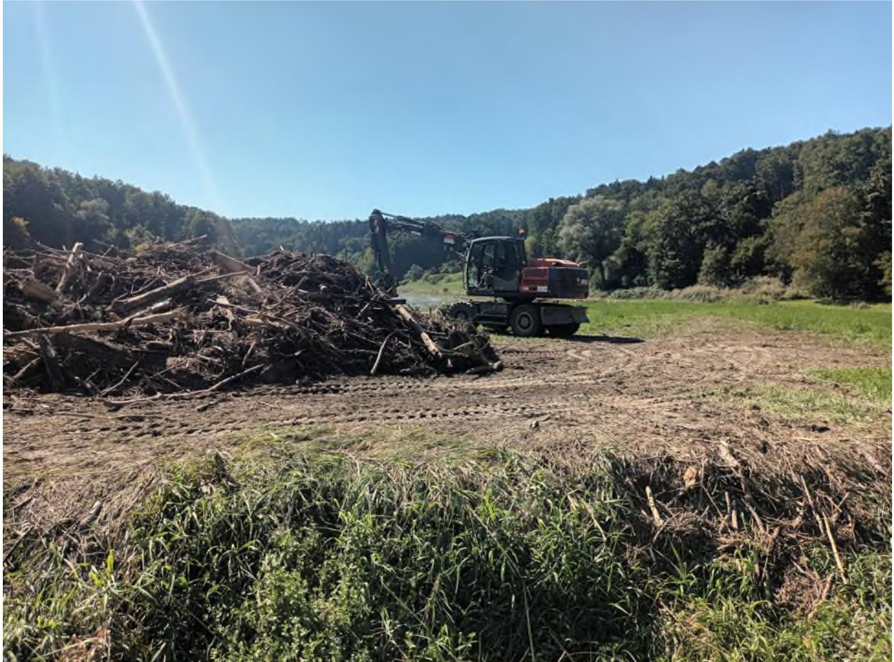
Abbildung 3: Ein Bagger räumt das Treibholz vom Uferweg und stapelt es zu einem großen Haufen.
