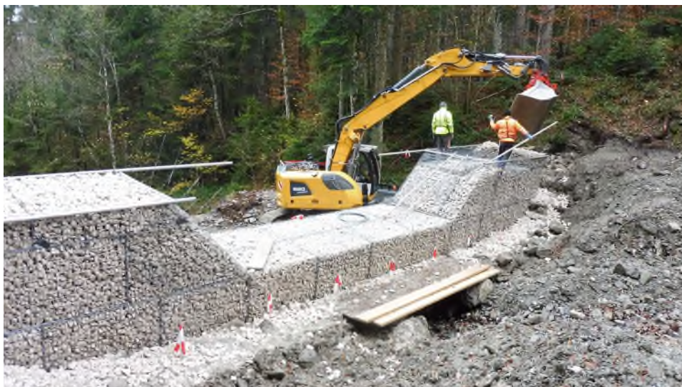
Abbildung 2: Ein Baggerfahrer füllt direkt vor Ort nach und nach die Drahtkörbe mit Steinen. Foto: Wasserwirtschaftsamt Traunstein
