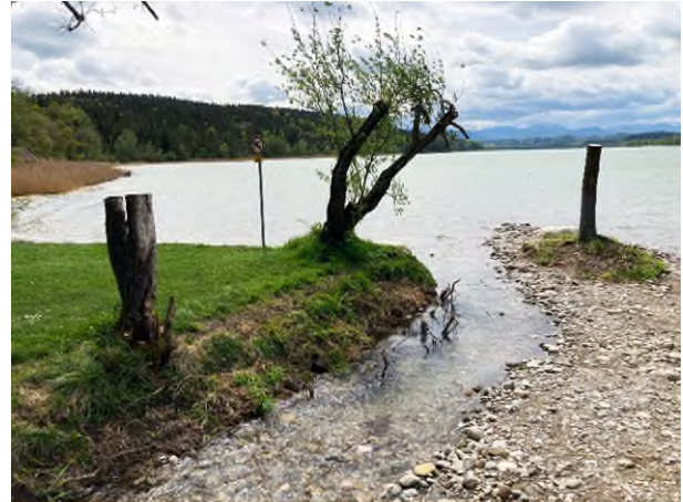
Abb. 4: Der neu gestaltete Mündungsbereich ist für Fische und andere Wasserorganismen wieder frei durchgängig. Die Sitzsteine laden zum Verweilen am See ein.
