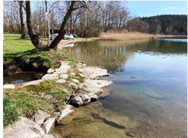
Abb. 2: Das massive Steinbauwerk schneidet den Tenglinger Bach (von links kommend) vom Tachinger See vor Beginn der Baumaßnahme ökologisch ab.
