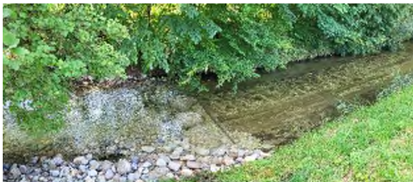
Abbildung 1: Der Unterschied ist deutlich zu erkennen: links ein Stück Bach nach der ökologischen Umgestaltung, rechts vor der Umgestaltung. Mit dem Ausbau der Bretter entstand eine mäandrierende Wasserrinne. Tief genug für Fische und dank der Steine auch mit reichlich Unterschlupfmöglichkeiten. Foto: Wasserwirtschaftsamt Traunstein
