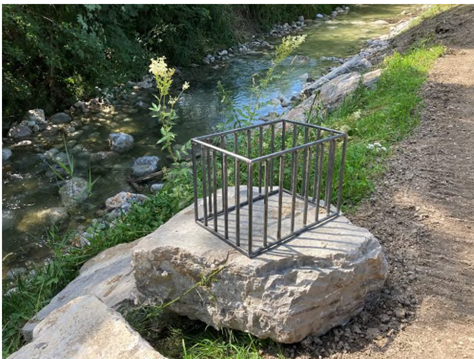
Abbildung 5: An einigen Stellen im Wössener Bach sind die Fischunterstände mit einem Gitterkäfig versehen. Eingebaut unter Wasser, bieten sie den Fischen die Möglichkeit sich vor Fressfeinden wie dem Fischotter zu verstecken. Diese Maßnahme ist eng abgestimmt mit dem Fischereiberechtigten Tobias Entfellner. Foto: Wasserwirtschaftsamt Traunstein
