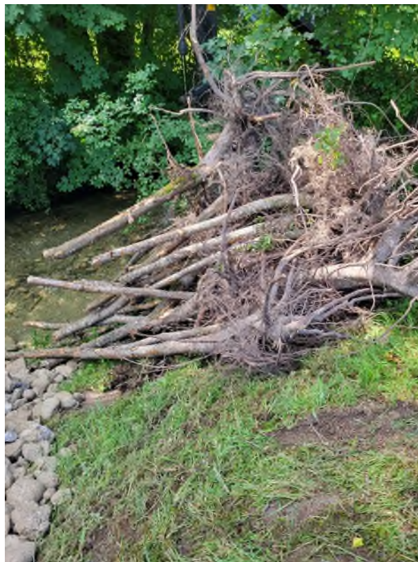
Abbildung 3: Diese Wurzelstöcke dienen Fischen bald als Unterstand im Bach. Mit dem Stamm nach unten werden sie im Bach eingebaut. Foto: Wasserwirtschaftsamt Traunstein
