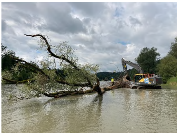
Abbildung: Neue Verankerung: Die rund 100 Jahre alte Weide wird in der Salzach befestigt. Wilhelm Hollinger von der Flussmeisterstelle Salzach, die zum Wasserwirtschaftsamt Traunstein gehört, überprüft die Verankerung des Baumes. Foto: Wasserwirtschaftsamt Traunstein
