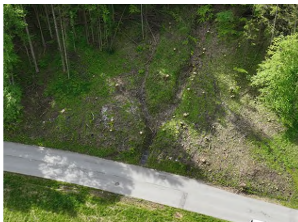
Abbildung 1: Die Aufnahme zeigt anschaulich die beiden Runsen des Reischklammbachs an der Alten Thumseestraße in Bad Reichenhall, Ortsteil Karlstein. Ebenfalls gut zu sehen ist der schmale Abflusskanal. Foto: Wasserwirtschaftsamt Traunstein
