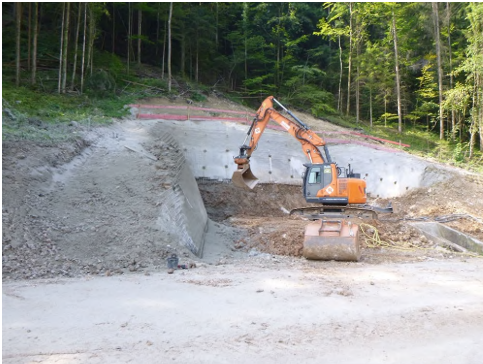
Abbildung 2: Nach Abschluss der archäologischen Arbeiten kann der Bagger seine Arbeiten auf der Baustelle an der Alten Thumseestraße in Bad Reichenhall fortführen. Foto: Wasserwirtschaftsamt Traunstein
