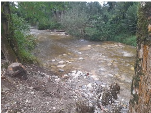
Abbildung 1: Die Steine im Wasser der Sur sind so eingebaut, dass Fische und Kleinstlebewesen sie gut überschwimmen können. Die sogenannte Sohlgleite ist unterhalb des Schwimmbads in Freilassing entstanden. Eine Steinschwelle hatte das Passieren bislang unmöglich gemacht. Foto: Wasserwirtschaftsamt Traunstein
