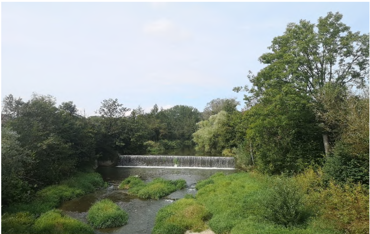
Abbildung 1: Der Absturz nahe der Brücke in Winhöring wird um fast zwei Meter abgefräst. In Kombination mit einer neu errichteten Sohlgleite können Fische nach Abschluss des Umbaus die Isen an dieser Stelle ohne Hindernis passieren. Foto: Wasserwirtschaftsamt Traunstein
