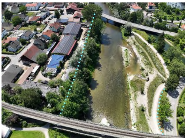
Abbildung 1: Die Drohnenaufnahme zeigt rechts den aufgeweiteten Be- reich in der Pechlerau. Hier und auch in der Saliterau (links im Bild) beginnen im Dezember die Bauarbeiten für die Hochwasserschutz- Mauern. Die gepunkteten Li- nien zeigen den Verlauf. Die Bäume in der Saliterau blei- ben erhalten. Foto: Wasserwirtschaftsamt Traunstein
