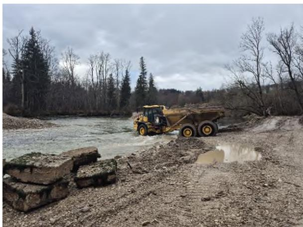
Abbildung 4: Während der Umgestaltungsarbeiten kommt schweres Gerät zum Einsatz. Unter anderem, um die Platten aus der alten Ufersicherung an der Alz auszubauen. Foto: Wasserwirtschaftsamt Traunstein
