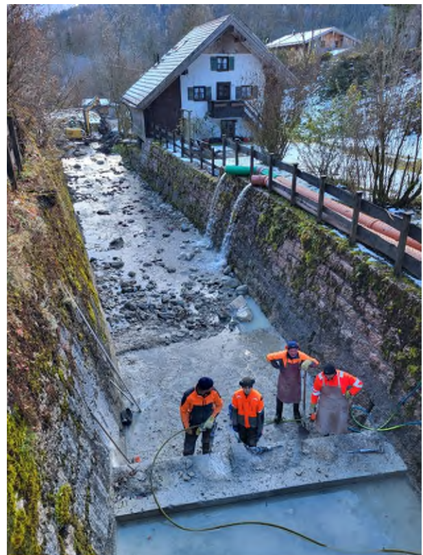
Abbildung 4: Die Arbeiter der Flussmeisterstelle Traun- stein arbeiten bei jedem Wetter draußen. Hier sanieren sie eines der Querbauwerke im Thoraubach im Ruhpol- dinger Ortsteil Haßlberg. Foto: Wasserwirtschaftsamt Traunstein
