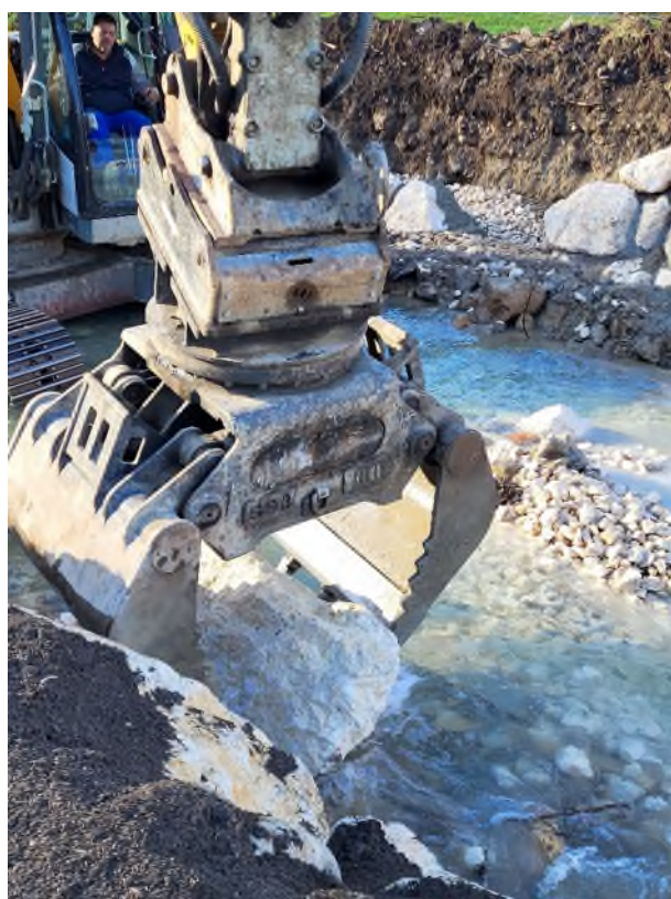
Abbildung 1: Uferbaustein für Uferbaustein hebt der Baggerfahrer aus dem Wasser und baut sie in die Uferböschung ein. Foto: Wasserwirtschaftsamt Traunstein
