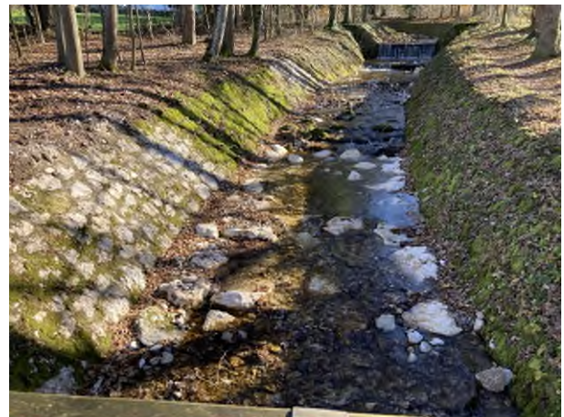
Abbildung 6: Die Schadstellen am Alpbach in Staudach haben die Arbeiter der Flussmeisterstelle Traunstein bereits saniert. Die Ufersicherung ist repariert. Foto: Wasserwirtschaftsamt Traunstein
