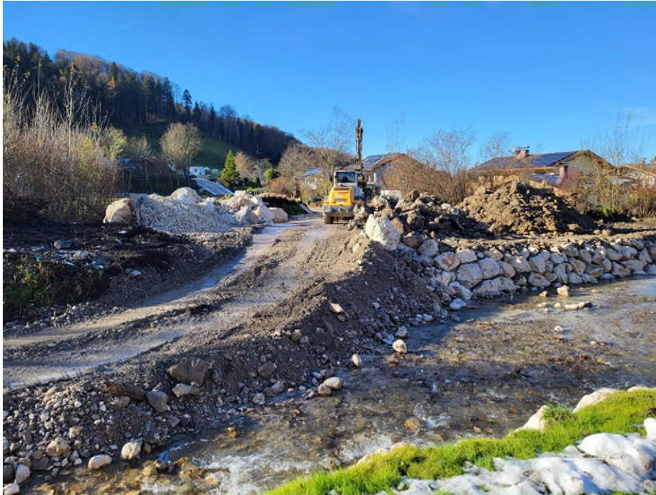
Abbildung 2: Für die Arbeiten in und an der Weißache in Ber- gen ist übergangsweise eine Fahrstraße im Fluss entstanden. Foto: Wasserwirt- schaftsamt Traunstein
