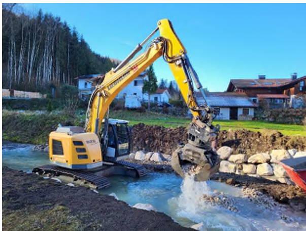
Abbildung 3: Zur Sicherung des Ufers der Weißache in Bergen schaufelt der Bagger nach und nach Kies an die Böschung. Foto: Wasserwirtschaftsamt Traunstein
