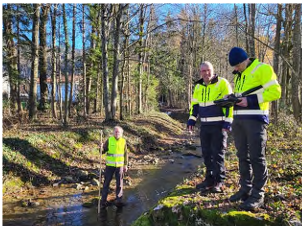
Abbildung 1: Gemeinsam prüfen (v.l.) Walter Hammerdinger, Stefan Hollrieder und Sepp Hauser den Zustand der Bauwerke und der Ufersicherungen am Alpbach in Staudach-Egerndach. Diese sogenannte Eigenüberwachung dient der Kontrolle und Sicherung von Bauwerken an verbauten Wildbächen im Amtsbezirk des Traunsteiner Wasserwirtschaftsamtes. Foto: Wasserwirtschaftsamt Traunstein
