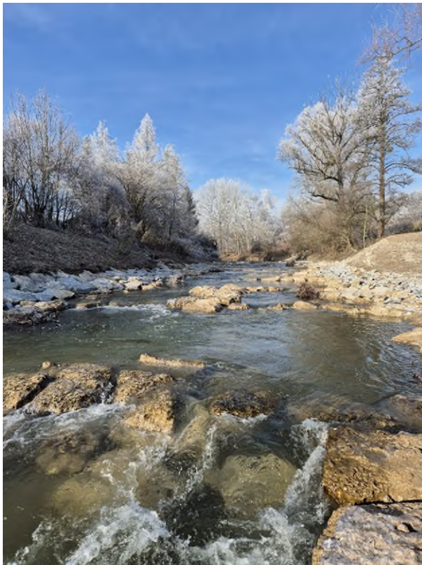
Abbildung 1: Das Bild zeigt den Baufortschritt an der Isen in der Winhöringer Ortsmitte vor Beginn der abschließenden Bauphase. Foto: Wasserwirtschaftsamt Traunstein
