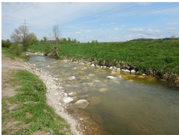
Abbildung 3: Die Aufnahme zeigt eine der drei Sohlgleiten, die im Rothgraben dafür sorgen, dass die Wasseroberfläche nach dem Kürzen der Spundwand flussaufwärts wieder hergestellt ist.
