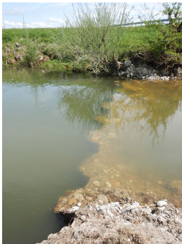
Abbildung 4: Die vormals 2,50 Meter hohe Spundwand im Rothgraben auf Höhe des Hundetrainingsgeländes ist um 40 Zentimeter gekürzt. Weil auch der Wasserspiegel angepasst ist, können Fische diese Stelle nun ohne Hindernis überschwimmen.
