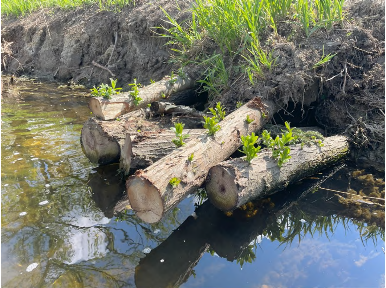
Abbildung 2: Unter den eingebauten Weidensetzstangen und Wurzelstöcken finden Fische Unterschlupf. Foto: Wasserwirtschaftsamt Traunstein
