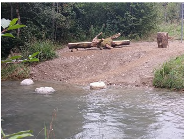
Abbildung 1: Der neue Rastplatz am Hammerauer Mühlbach bei Freilassing. Foto: Wasserwirtschaftsamt Traunstein
