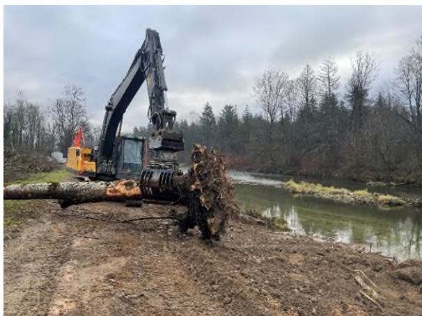
Abbildung 1: Der Bagger hält einen Baumstamm, der in der neuen Insel verankert werden soll. An ihr soll sich künftig Treibholz ansammeln können. Foto: Wasserwirtschaftsamt Traunstein
