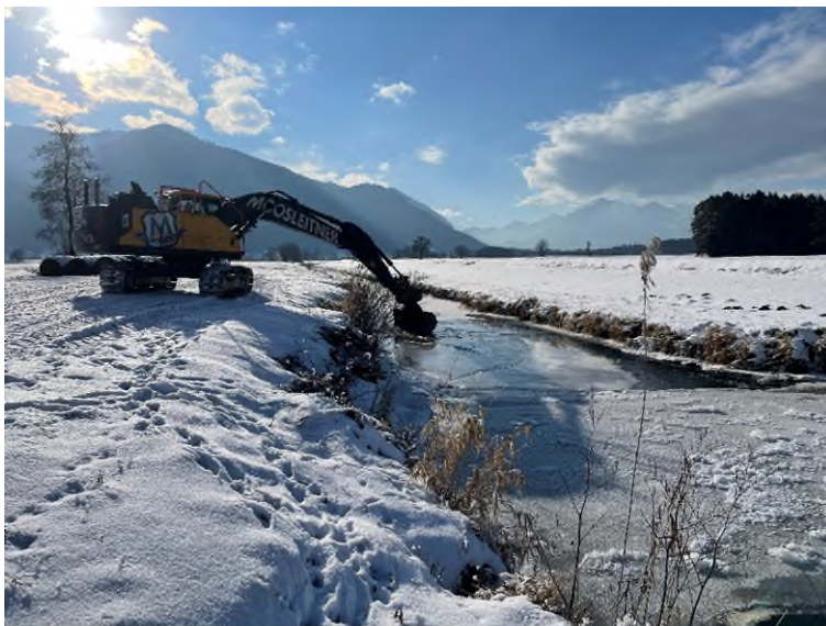
Abbildung 2: Mit Hilfe eines Baggers wird der Absturz an der Weißen Achen bei Bergen/Grabenstätt umgestaltet
