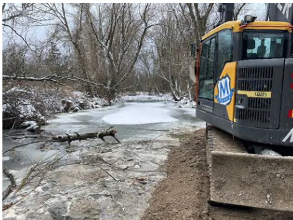
Abbildung 1: Gerade noch Standplatz für den Bagger, demnächst Sohl- gleite: Aufgeschütteter Kies in der Sur dient zunächst als trockener Stellplatz für den Bagger. Bald aber bildet er die Unterkonstruktion für die Sohlgleite. Foto: Wasserwirtschaftsamt Traunstein
