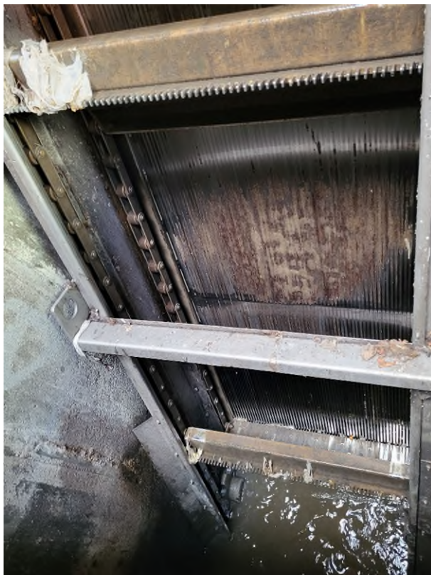
Abbildung 4: Der Grobrechen hält größeren Unrat zurück. Ein weiterer, feinerer Rechen separiert kleinsten, lediglich Millimeter große Inhaltsstoffe. Foto: Wasserwirtschaftsamt Traunstein
