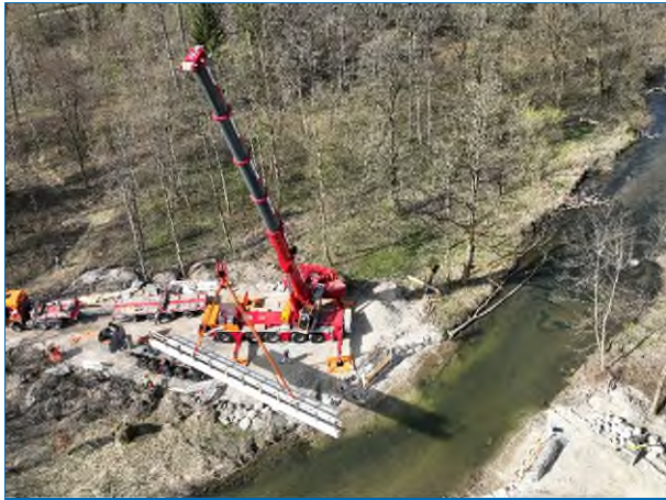
Abbildung 1: Mit einem Autokran wurden die beiden Fertigteile eingehoben. Derzeit liegen die Fertigteile noch auf hölzernen Traggerüsten auf. In den kommenden Tagen wird der Anschluss an die Widerlager hergestellt. Foto: Wasserwirtschaftsamt Traunstein
