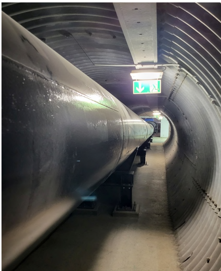
Abbildung 1: Ehe die alte Betriebsauslassleitung ausgebaut werden konnte, musste sie zerteilt werden. Die einzelnen, rund 1200 Kilogramm schweren Teile wurden mit Hilfe von kleinen Wagen hinausgezogen aus dem Stollen. Foto: Wasserwirtschaftsamt Traunstein
