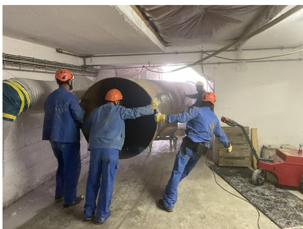
Abbildung 1: Ehe die alte Betriebsauslassleitung ausgebaut werden konnte, musste sie zerteilt werden. Die einzelnen, rund 1200 Kilogramm schweren Teile wurden mit Hilfe von kleinen Wagen hinausgezogen aus dem Stollen. Foto: Wasserwirtschaftsamt Traunstein
