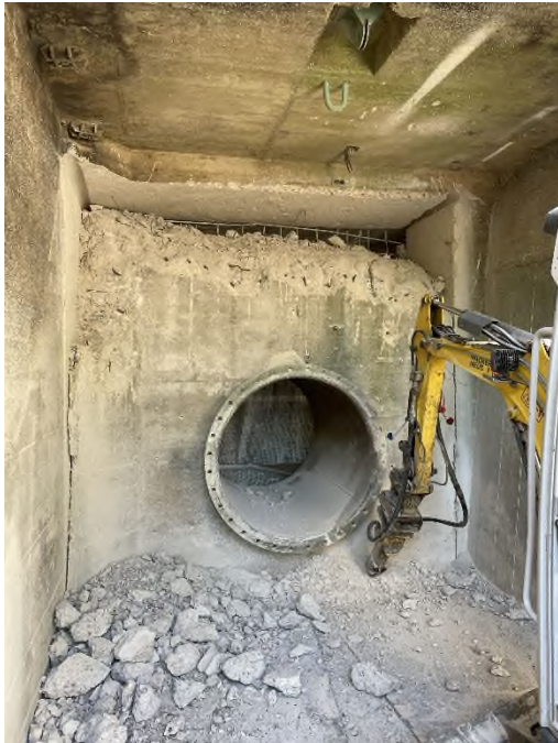
Abbildung 4: Nach dem Ausbau des Kegelschleiers aus seiner Öffnung musste die gesamte Wand aufgestemmt werden, um Platz zu schaffen für den Ausbau der alten Rohrleitung. Foto: Wasserwirtschaftsamt Traunstein
