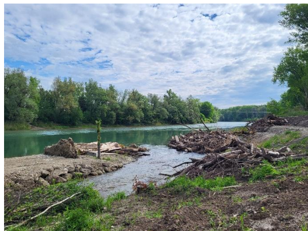
Abbildung 4: Die neu gestaltete Mündung des Hirsch- bachs in den Inn können Fische ohne Hindernis durch- schwimmen. Das Totholz wird der Fluss nach und nach mitnehmen. Auch das macht Sinn, denn Totholz dient ebenfalls der Ökologie: Fische können es beispielsweise als Unterschlupf und Schutz vor Fressfeinden nutzen. Foto: Wasserwirtschaftsamt Traunstein
