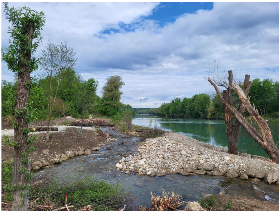
Abbildung 2: Der Hirschbach ist um- gestaltet und fließt nun auf einer Strecke von 240 Metern mäandierend parallel zum Inn, in den er dann mündet. Totholz in und am Wasser wer- tet die ökologische Struktur auf. Foto: Wasserwirt- schaftsamt Traunstein
