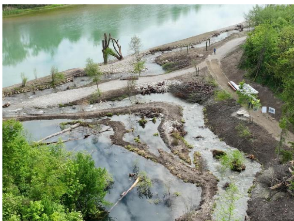
Abbildung 3: Die Drohnenaufnahme bietet einen Über- blick über einen Großteil des neu gestalteten Areals. Foto: Wasserwirtschaftsamt Traunstein
