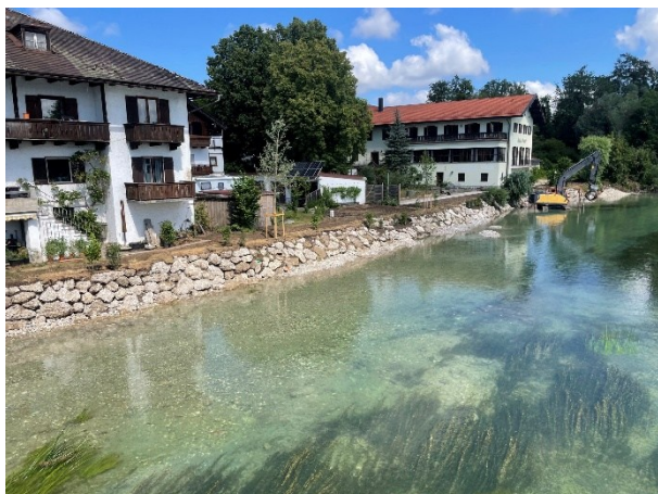
Abbildung 1: Die neue Ufersicherung besteht aus Nagelfluh-Steinen, in deren Fugen Gras und Pflanzen wachsen werden. In kleinen Nischen finden unter anderem das Pfaffenhütchen und der Gemeine Schneeball Platz. Im Kies sind Schilfwurzeln vergraben. Foto: Wasserwirtschaftsamt Traunstein
